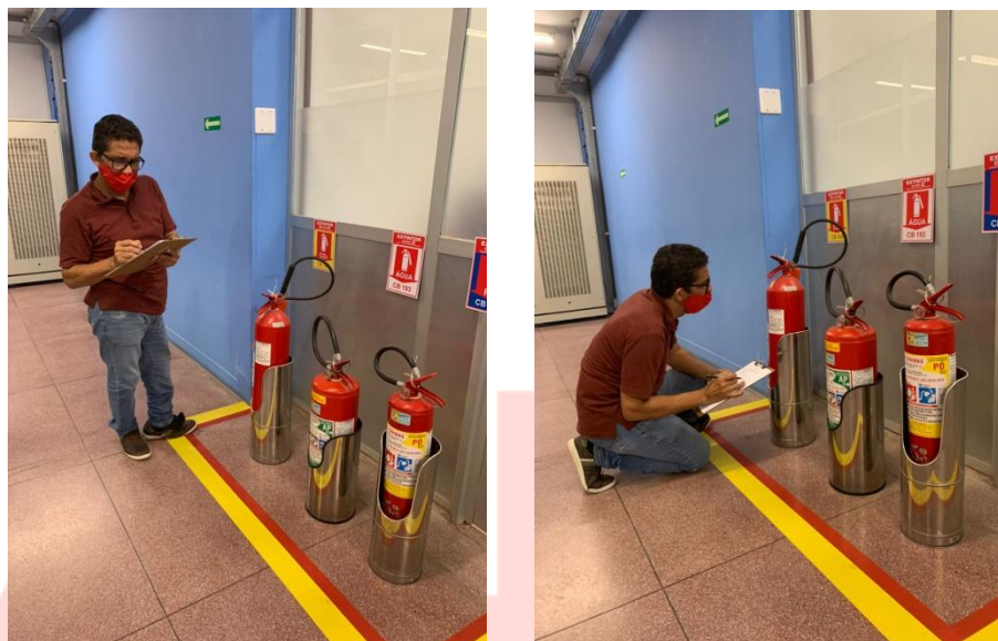
Fonte: COCOM: inspeção dos extintores de incêndio.
