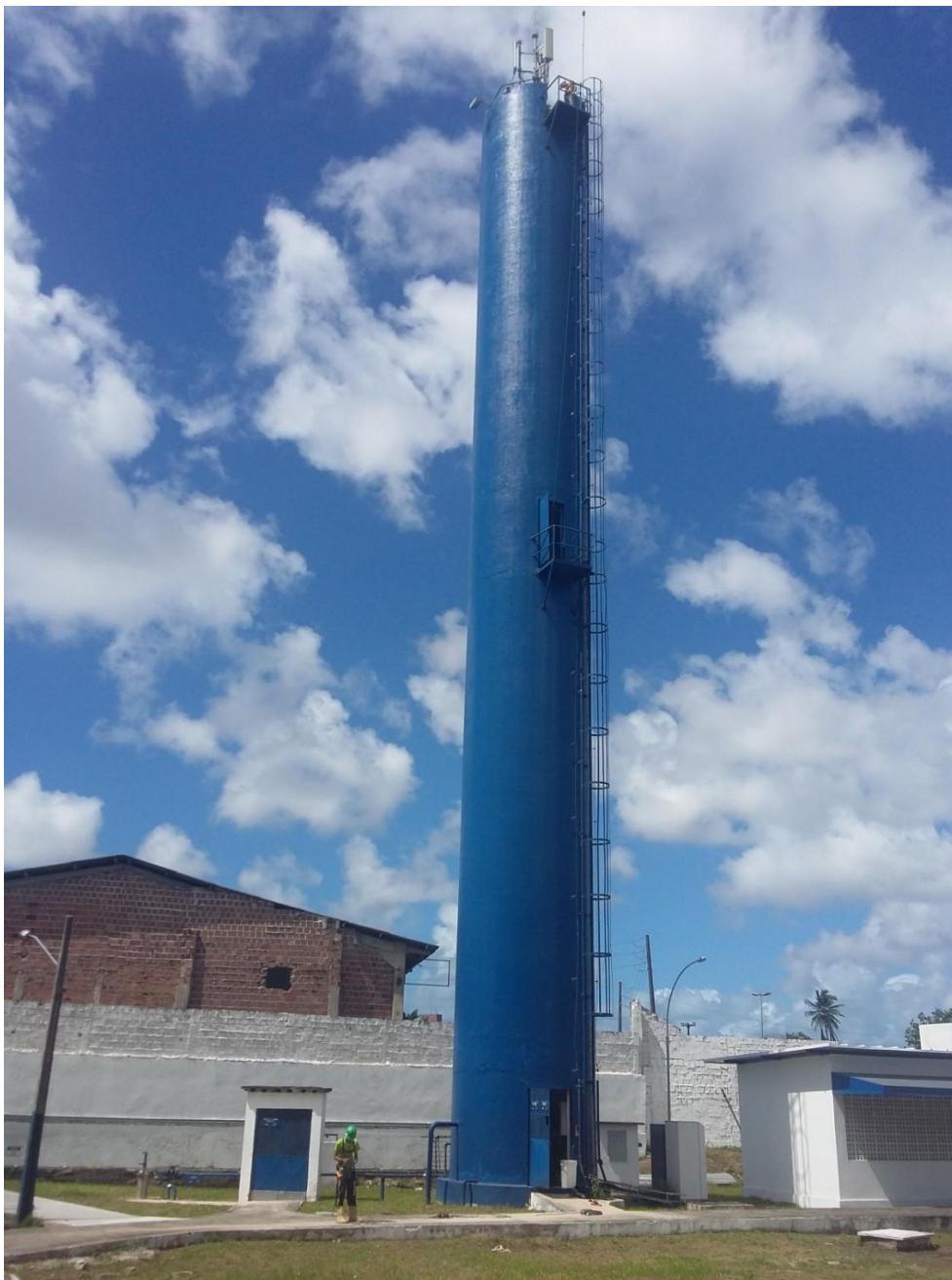
Figura: Reservatório de abastecimento de água
