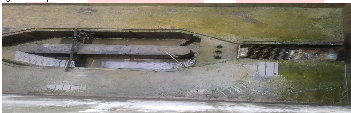
Figura: Calha parshall
