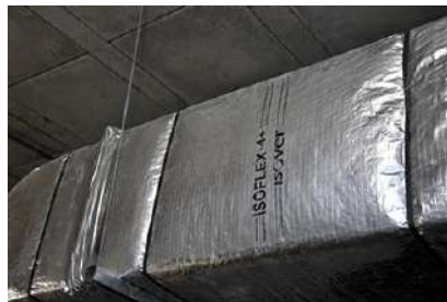
Imagem 08 – Isolamento em lã de vidro e papel kraft - Imagem ilustrativa
