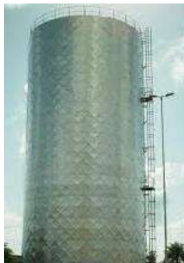
Imagem 06 – Tanque de termoacumulação - Imagem ilustrativa
